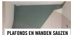
PLAFONDS EN WANDEN SAUZEN
